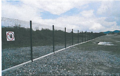
Clôture intérieure fosses à noir
