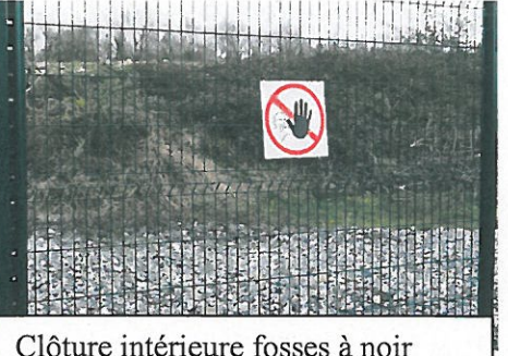
Clôture intérieure fosses à noir
