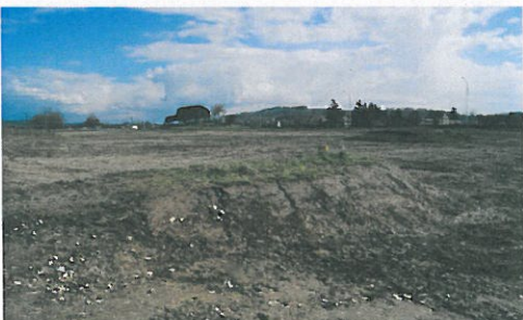
Excavation de terres naturelles sur les parcelles 10 et 15, le piézomètre P11 est ancré dans une langue de terres maintenues en place
